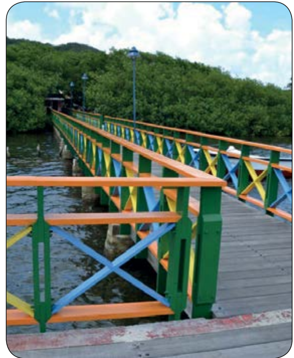
Foto: restauración obra el fuerte en San Andrés y Provicencia
