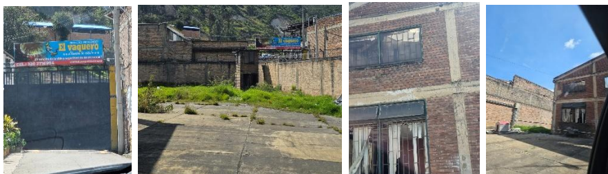
Fuente: Imágenes tomadas en data center alterno.
