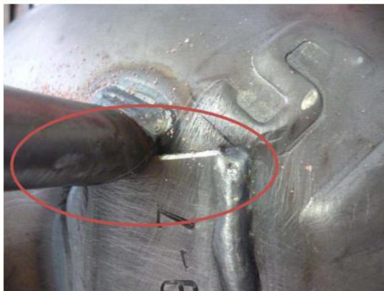
Figura 3. Impedimento de la soldadura al 100% por sobredimensión
