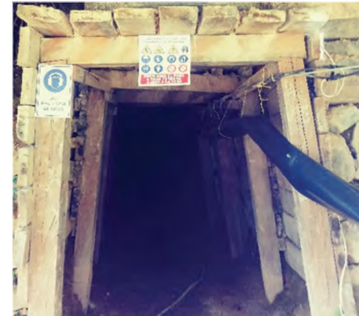
Fotografía 5.5. Bocamina Principal San Pedro. Fuente: autores.
