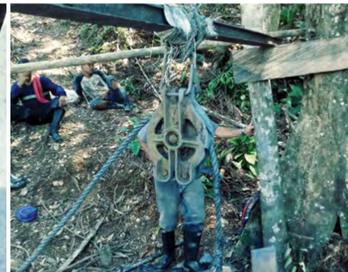
Fotografía 5.2. Garrucha para extracción de material de la clavada. Fuente: autores.
