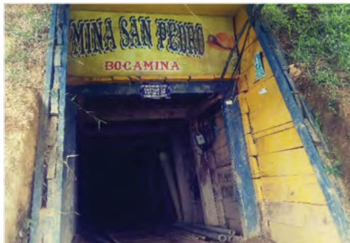
Fotografía 5.7. Bocamina Principal San Pedro. Fuente: autores.
