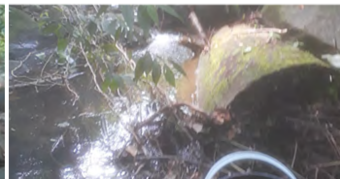
Fotografía 7.7. Quebrada la Ceiba, aguas abajo. Fuente: Autores.
