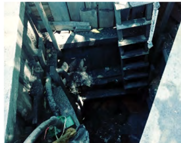
Fotografía 5.1. Mina Río Gold en construcción. Fuente: autores.
