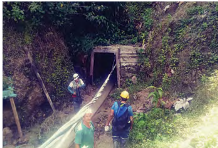
Fotografía 5.3. Bocamina La Cirila. Fuente: autores.
