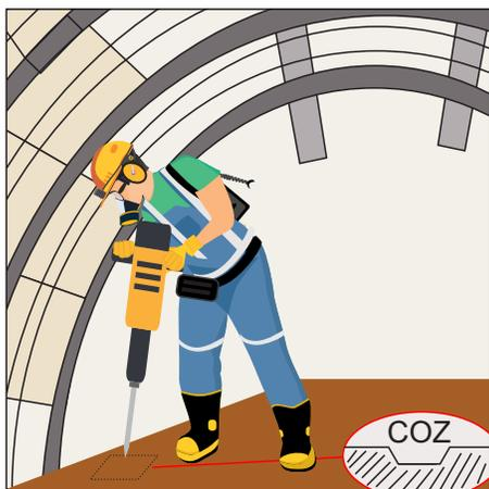
**F. Construya la coz en el sitio marcado un poco más grande que la zapata metálica y de madera.**
