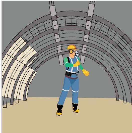
C . Perforar malla de pernado, según las indicaciones de geomecánica y plan de sostenimiento.
