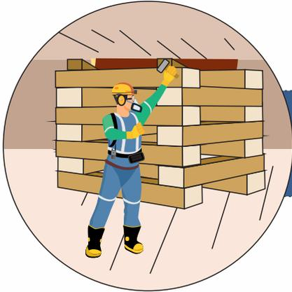
F. Cuando se termina de superponer todos los polines (Uno sobre el otro), se ajustan los dos últimos (superiores) polines con cuñas en los extremos.
