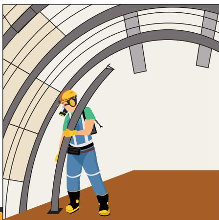
**H. Coloque una zapata de polín en dirección al frente y luego levante una palanca y colóquela con la plataforma metálica sobre el polín.**
