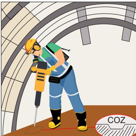
**F. Realice la coz en el sitio marcado un poco más grande que la zapata metálica y de madera.**
